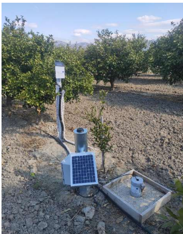
Slika 6. Višeparameterska sonda za praćenje stanja podzemnih voda instalirana u piezometru
