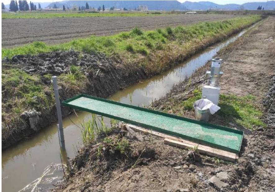
Slika 2. Višeparametarska sonda za praćenje stanja površinskih voda instalirana u kanalu
